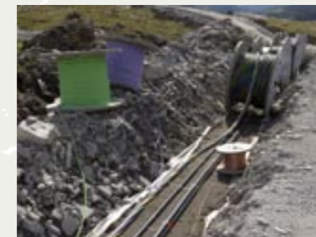
Kabelarbeid på Bessakerfjellet Foto: T. Wuttudal
